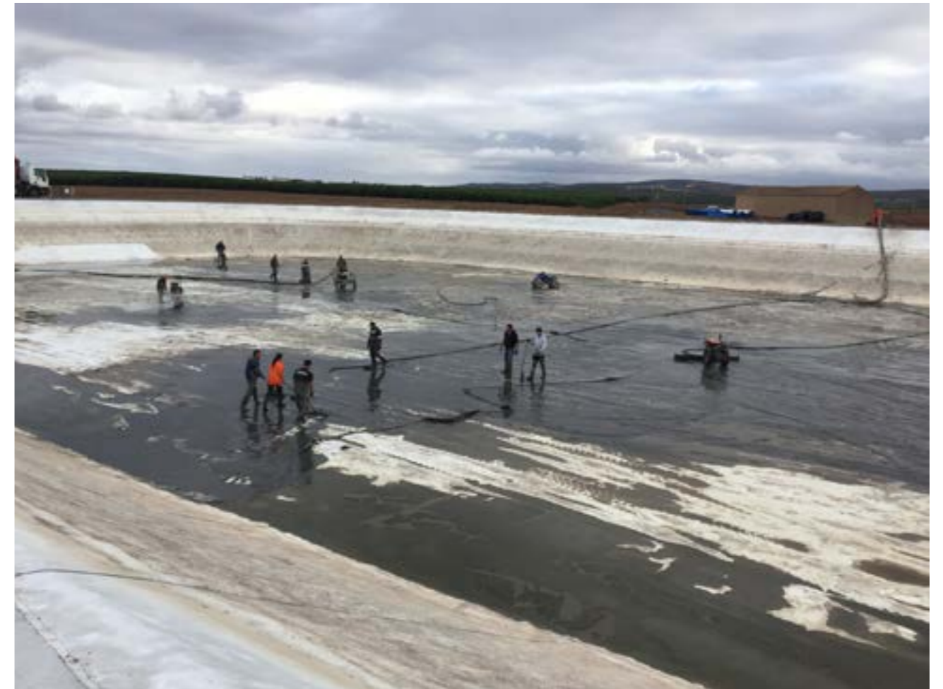
Operações de remoção de mexilhões-zebra e limpeza, no reservatório do Alfundão. Foto: David Catita
