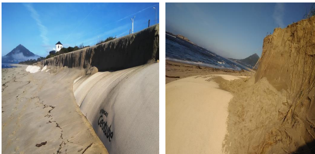
Figura 10 - Duna da praia de Moledo após uma tempestade em dezembro de 2019, com geotubo exposto.
